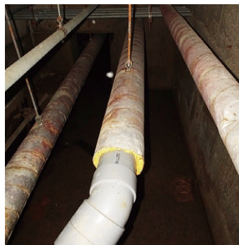
高圧洗浄を行う中学校排水管
