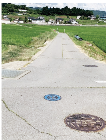
町道野方赤沢線…通学路・生活道路・農道の役割があり、改善が期待される。
