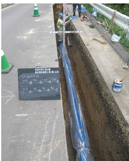
本管布設替の様子
