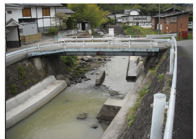
藤沢の「下村橋」
