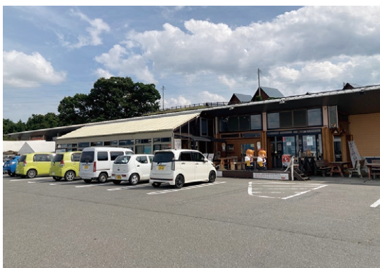
改修が待たれる 「道の駅 女神の里たてしな」の中核施設
