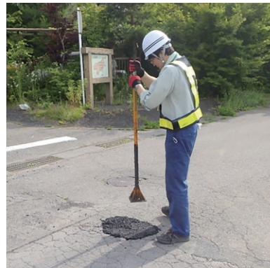
現在の穴埋め作業の様子
