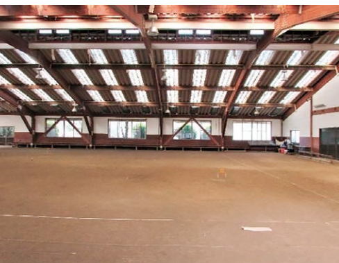
より利用が望まれる屋内運動場
