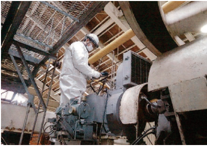
振動検査の様子
