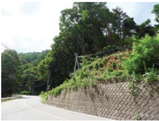
県道40号沿い支障木伐採地（芦田財産区）
