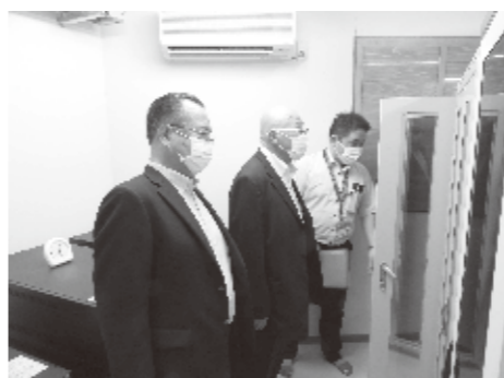
白樺高原総合観光センターに整備された光伝送路監視装置等を現地視察。
