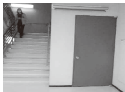
エレベーター設置予定場所 (庁舎階段横)
