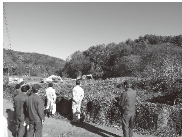
家畜ふん尿除去による農地復旧現場
