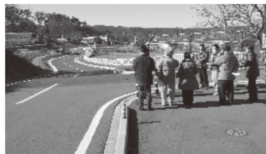
完成した町道小学校線
