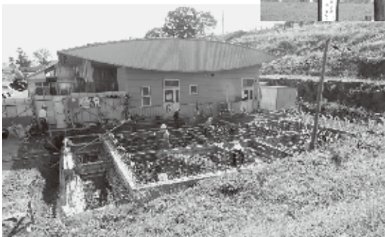
工事の進む道の駅「女神の里たてしな」
