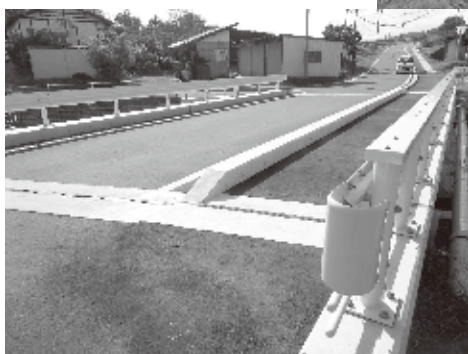
H28竣工 真蒲橋
