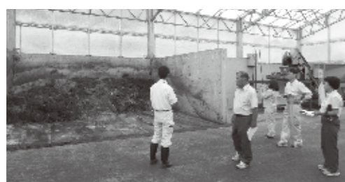
長和町堆肥化処理施設
