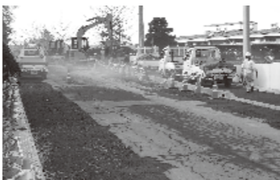
工事の進む町道小学校線
