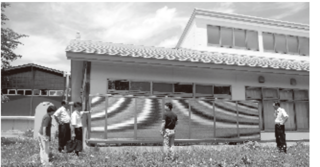
健康支援センター女神 雪害対策軒屋根工事の説明を受ける。 補正予算50万円。
