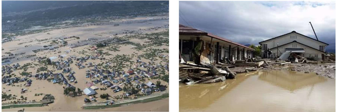
図 3-20 令和元年東日本台風による洪水被害の状況
