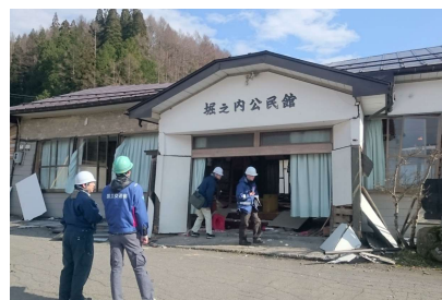
長野県神城断層地震（H26.11.22）
