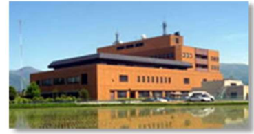
【災害拠点の割増補強】 (松本合同庁舎)
