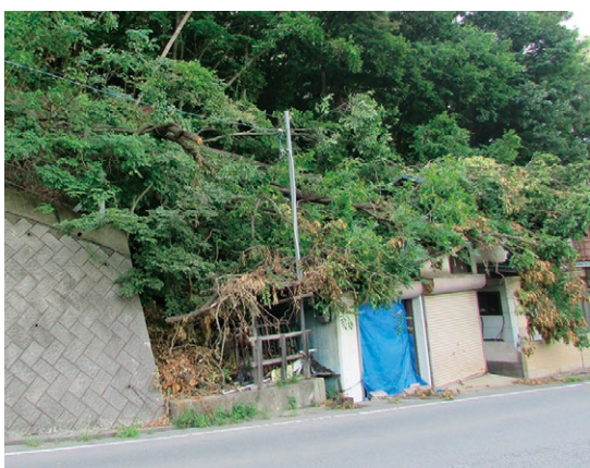
豪雨災害による倒木現場
