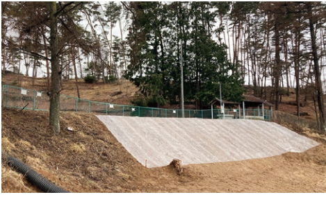
権現山キャンプ場復旧箇所
