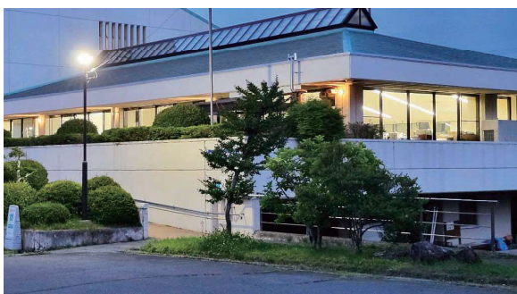
遅くまで電気の灯る立科町役場
