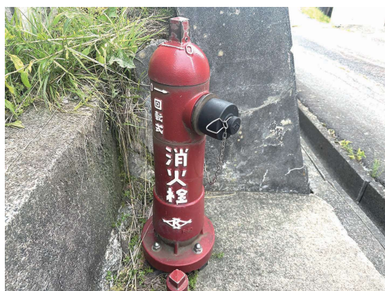
消火栓更新の地元区負担は軽いものではない。
