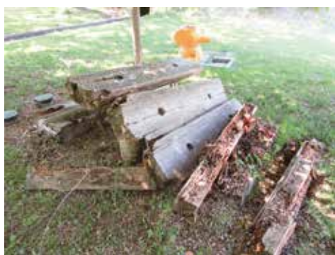
壊れた木製テーブル (風の子広場・藤棚の下)
