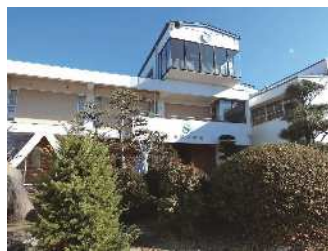
老朽化が進む立科小学校
