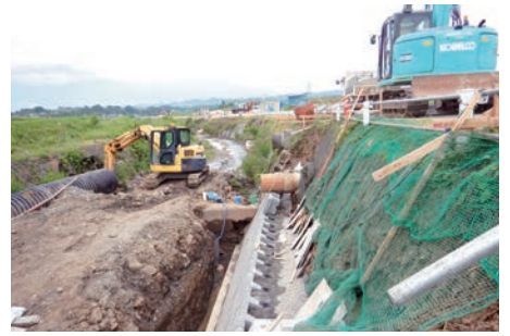
施工中の(一)芦田川 立科町 国道下(1)の現場
