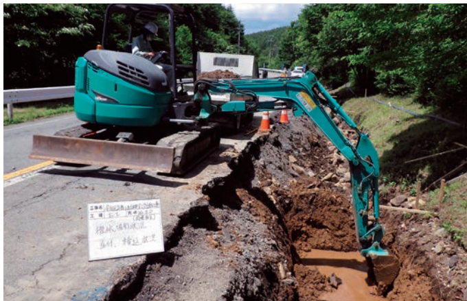
施工中の (一) 芦田川 立科町 切掛(1)の現場
