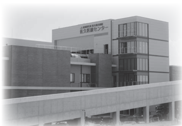
建設工事中の佐久医療センター
