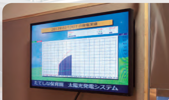
太陽光発電システム
