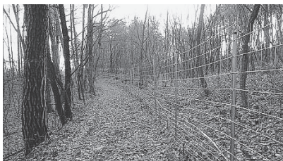
有害鳥獣対策防護柵
