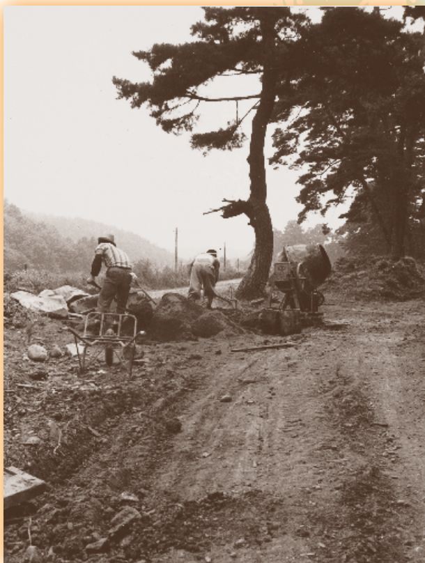
松並木公園駐車場から芦田側にある土塁
