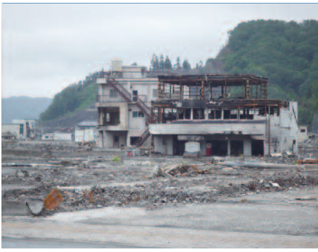
瓦礫の撤去が進む市街地の様子
