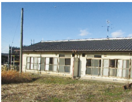
移住者向け改修中の教員住宅
