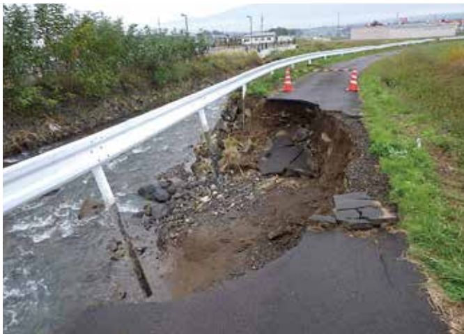
町道堀越峯二号線(茂田井)
