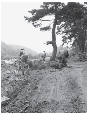
昭和42年国道工事写真
